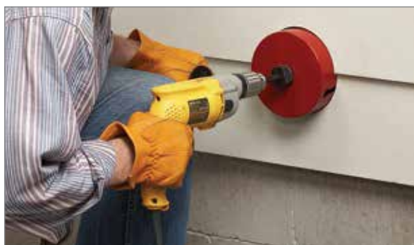
Realiza agujeros limpios en paredes revestidas de paneles de fibra de cemento.
